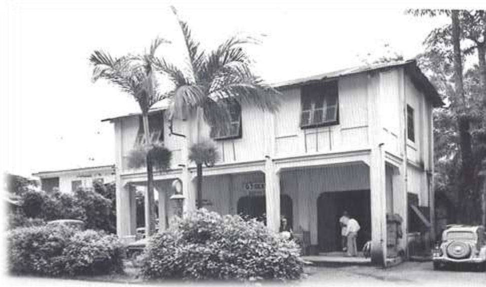
Photo 2. Commerce Tsékénis sur la rue Pau à Douala, une maison moderne pour l'époque coloniale
